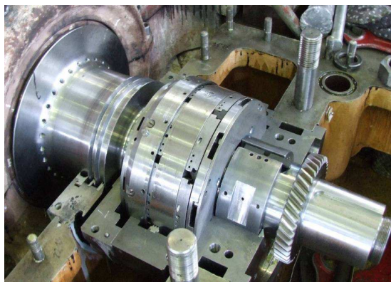
Рисунок 6 – Подшипник опорно-упорный ПДУ-120/260 во время монтажа
